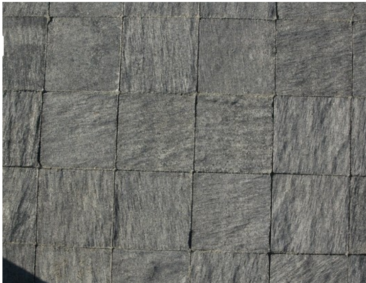
Tipologia dei masselli autobloccanti previsti sull’intersezione Via Roma-Via Adua
