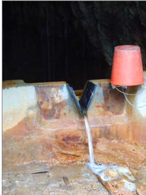
Figura 2.25. Stramazzo collocato all'uscite della galleria di Ribasso del Pollone in un momento di deflusso significativo (12.02.2016).
