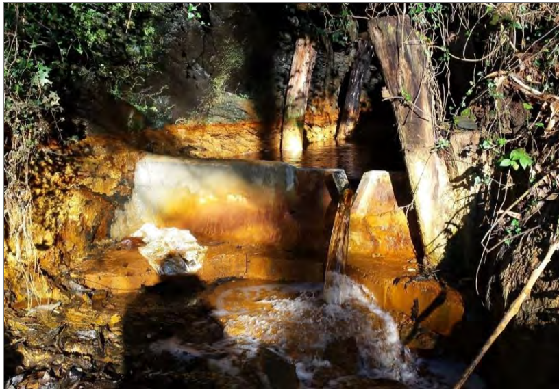
Figura 2.26. Stramazzo collocato all'uscite della galleria Sant'Erasmus in un momento di deflusso significativo (10.02.2016).
