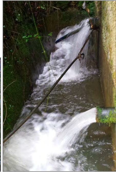
Figura 2.17. A sinistra: esterno del bottino di presa della sorgente Molini di Sant'Anna (VSMSA); a destra: i tubi di scarico e troppo pieno durante un evento di piena (05.01.2016).
