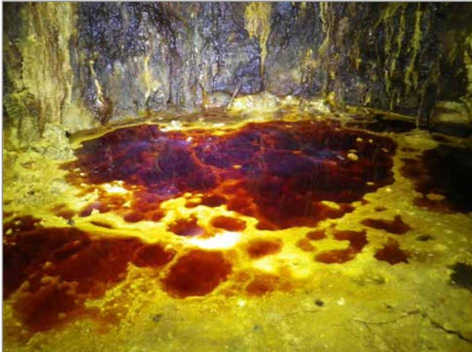
Figura 4.21 – Stillicidi dalla volta con pozza di ristagno di acque contaminate (Miniera del Pollone, livello Rosina).
