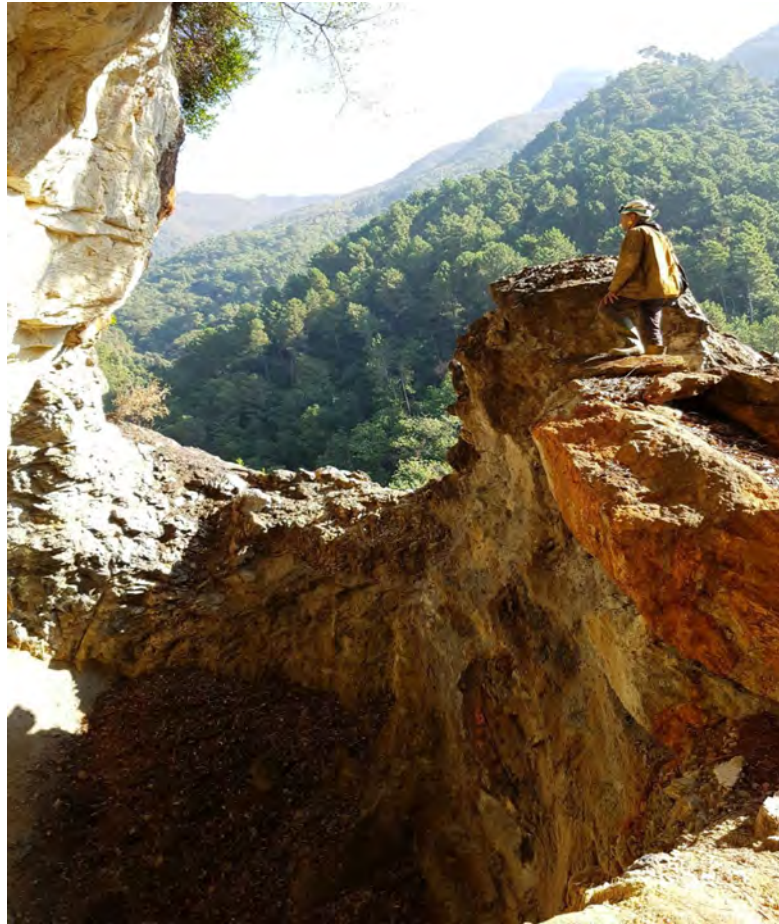
Foto 6: per impedire l'ingresso delle acque meteoriche e la realizzazione di una tettoia in corrispondenza dello spigolo nord, previa la riduzione dell'attuale cavità. Per quest'ultima operazione verranno utilizzati i massi che verranno prodotti dall'eliminazione dello sperone di roccia sulla destra della foto
