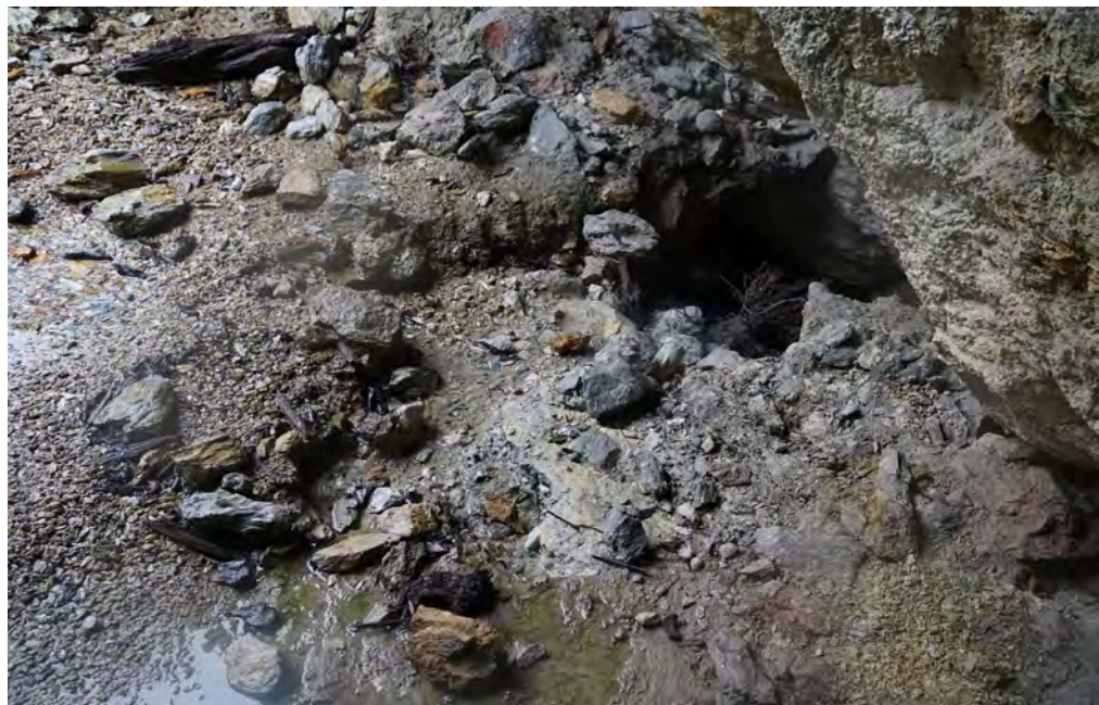
Foto 5: i lavori prevedono l'eliminazione di diversi punti di ingresso delle acque meteoriche nel sistema minerario. Qui è ripreso un punto di ingresso delle acque al livello 244
