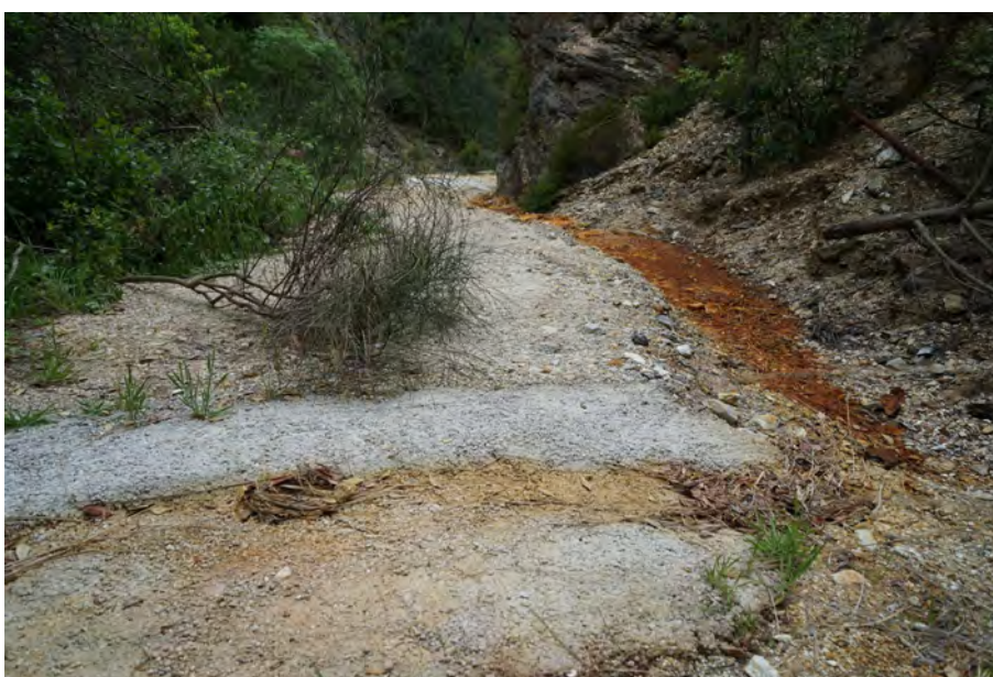
Foto 1: fenomeni di lisciviazione del fondo stradale a carico delle acque meteoriche. Qui è prevista l'impermeabilizzazione del fondo in calcestruzzo armato
