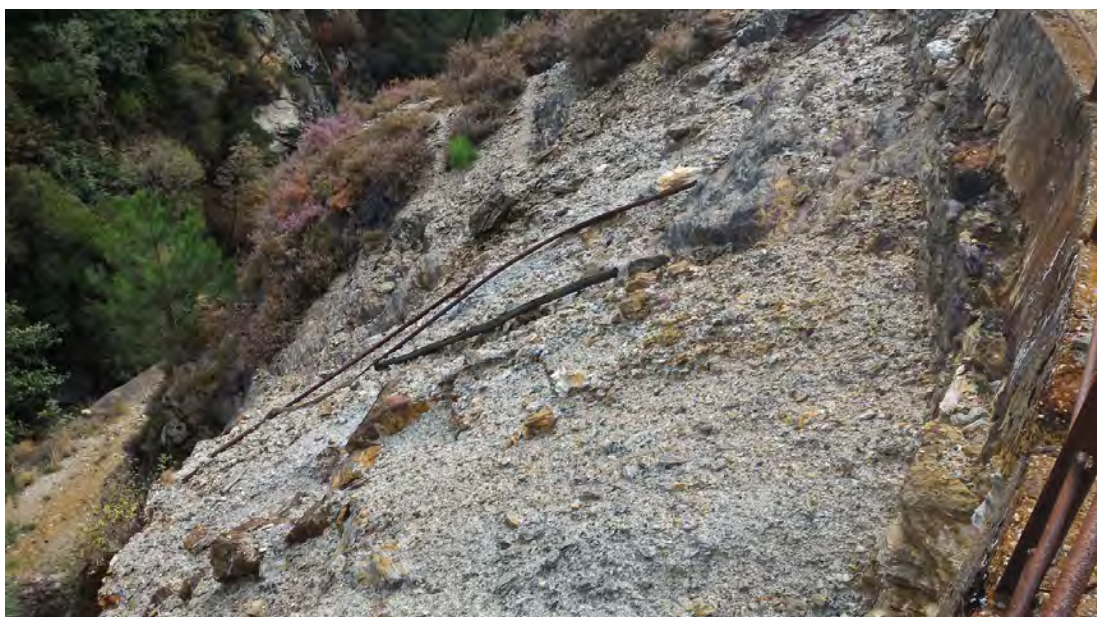
Foto 7-8: panoramiche di alcuni tratti del versante in cui è prevista la rimozione dei detriti ed il disgaggio di alcuni blocchi isolati.
