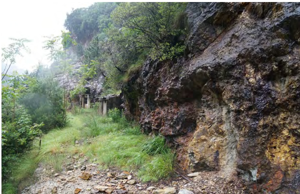
Foto 4: strada di miniera nel tratto superiore. Qui è prevista l'impermeabilizzazione del fondo in calcestruzzo armato e la sigillatura di alcuni punti di infiltrazione verso il vecchio sistema francese.
