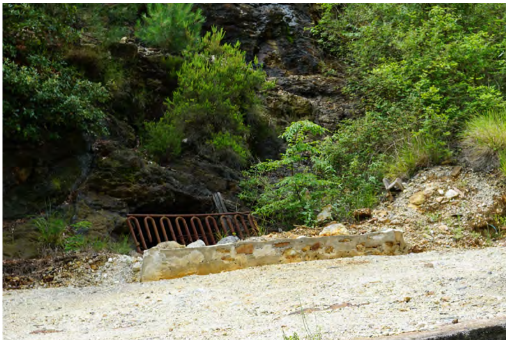
Foto 2: discenderia Rosina. Qui è previsto di realizzare una tettoia ed un setto impermeabile al bordo strada per evitare l'infiltrazione delle acque meteoriche
