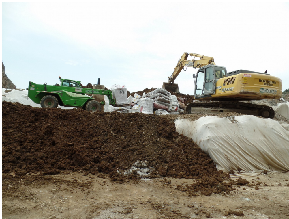
Foto 7: scarico messa a dimora e copertura RCA
