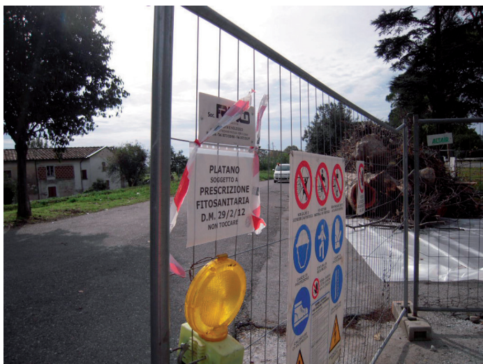
Foto 8 - sito di stoccaggio temporaneo recintato ed inaccessibile ad estranei
