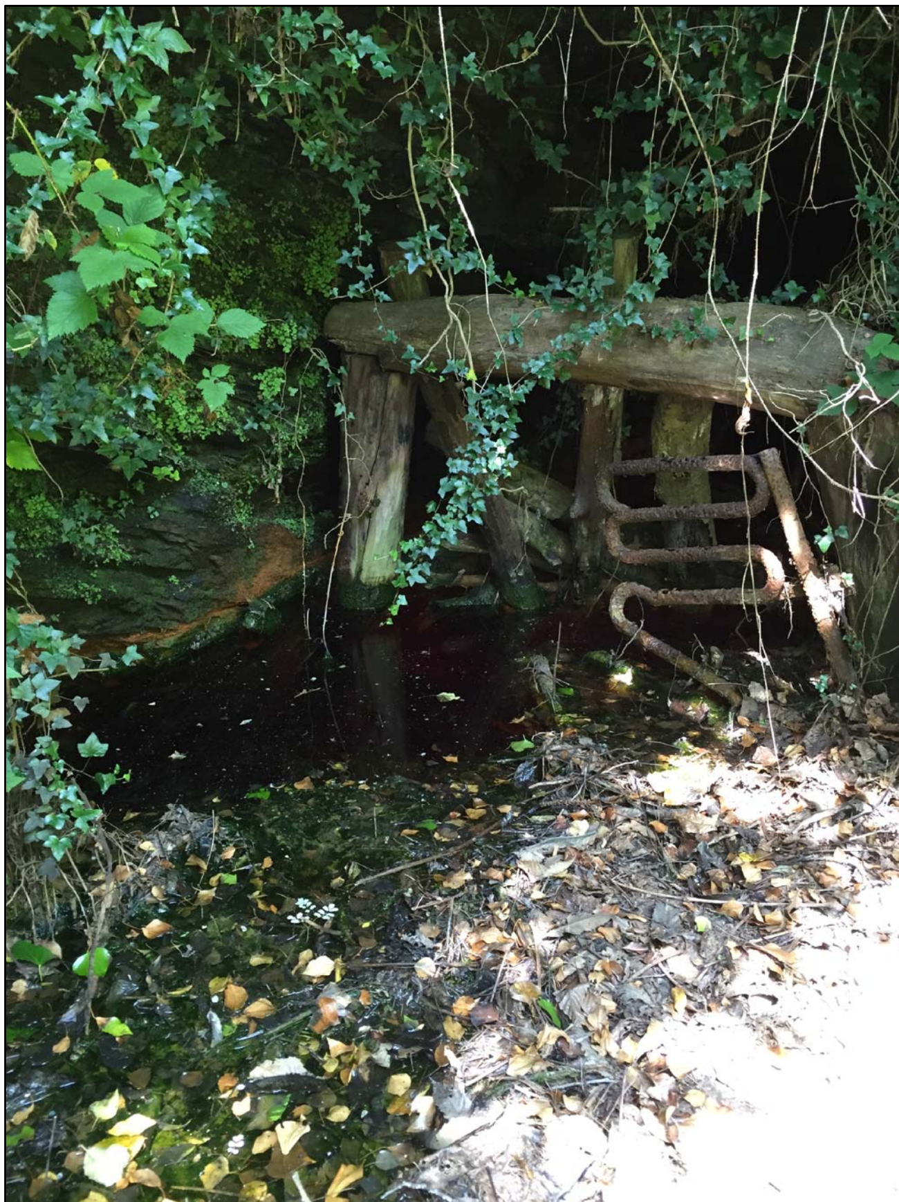
FIG. 5 INGRESSO GALLERIA S.ERASMO
