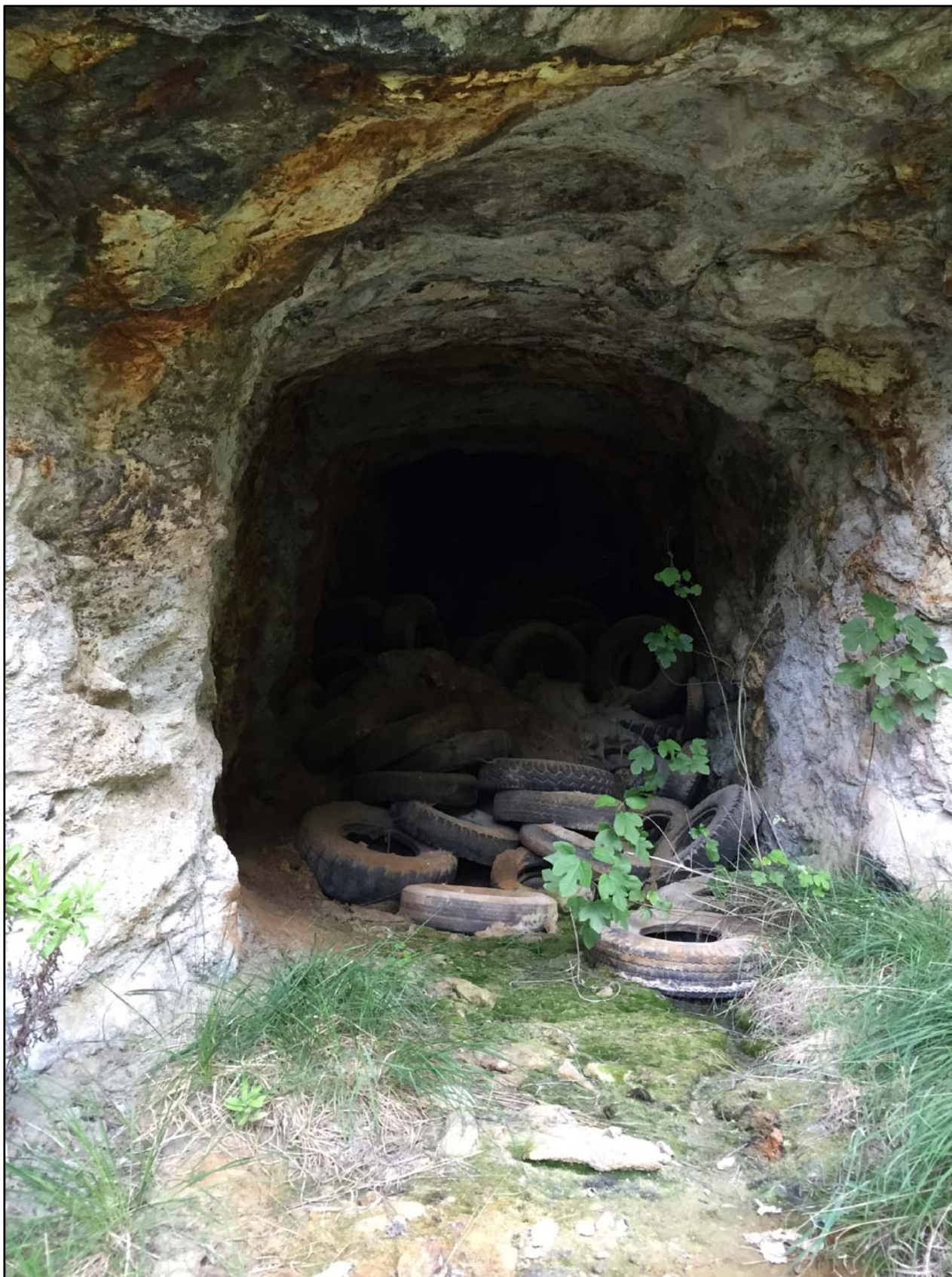
FIG. 35 INGRESSO GALLERIA CUGNASCA 3
