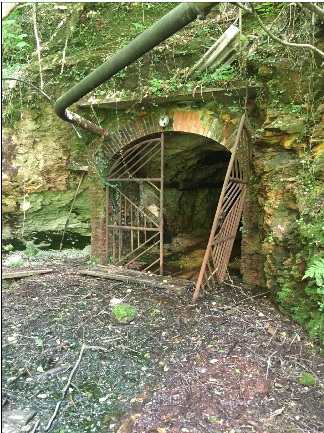
FIG. 8 INGRESSO GALLERIA S.ANNA
