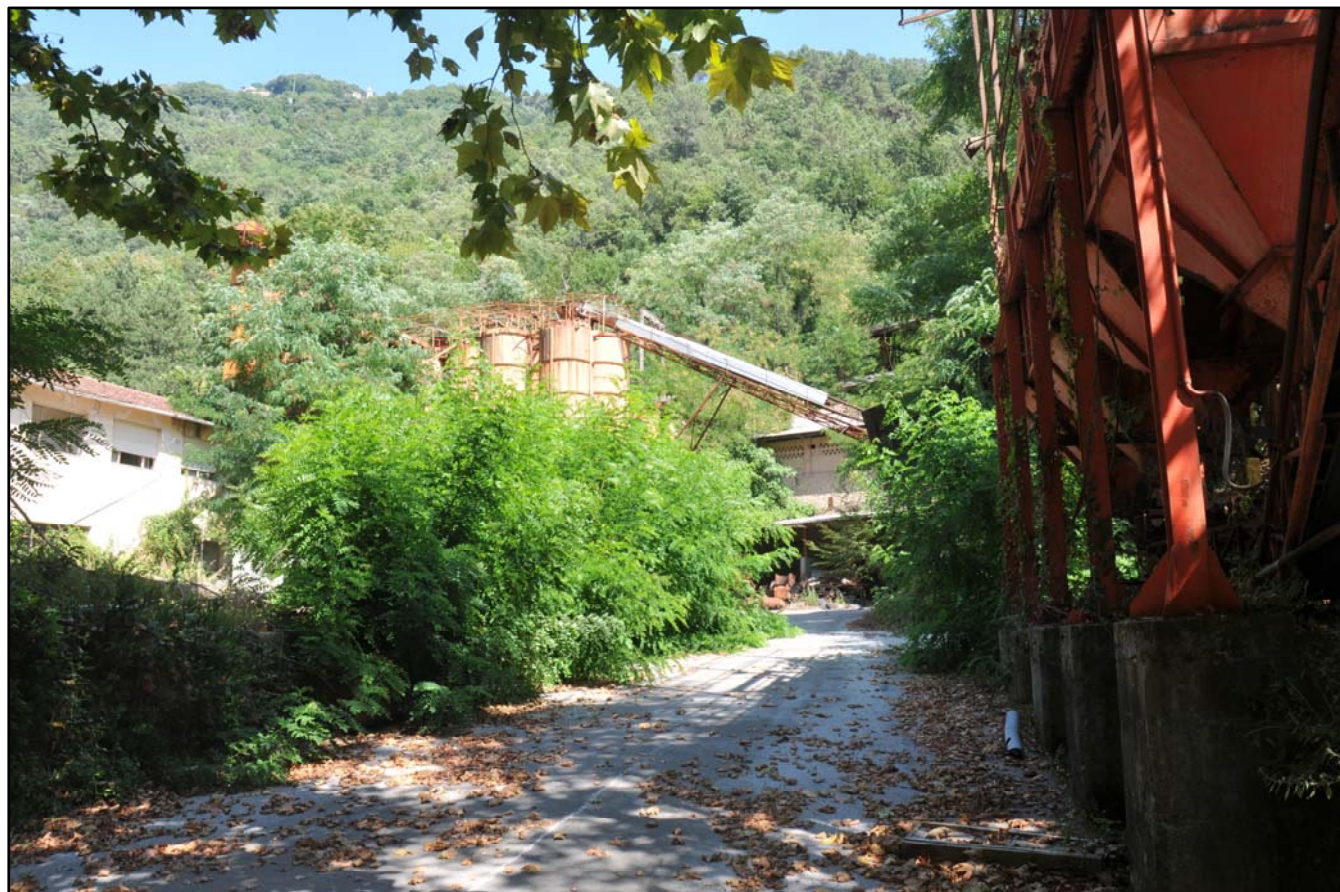
FIG. 36 MANUFATTI ABBANDONATI DELLO STABILIMENTO DEL REZZAIO
