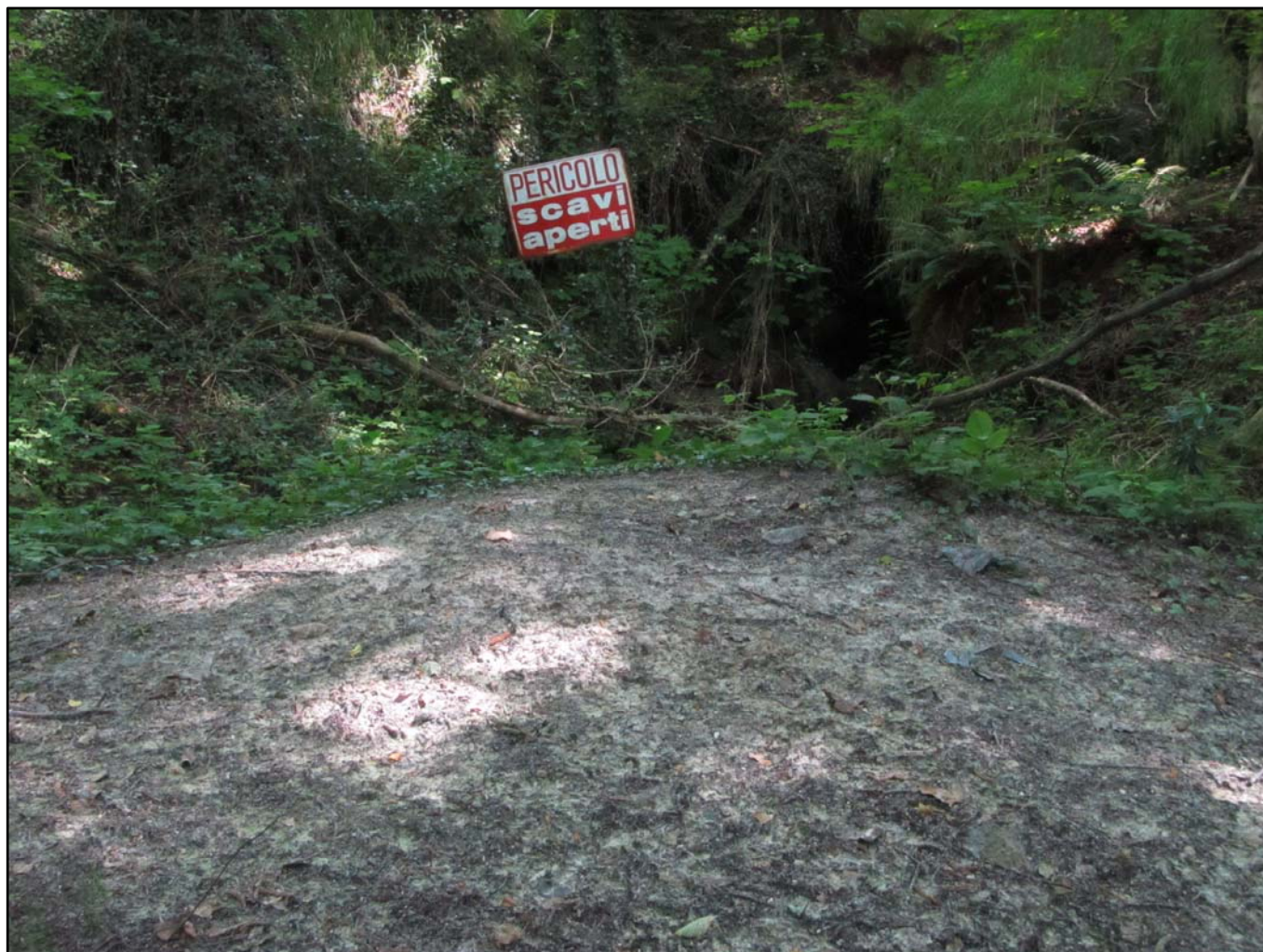
FIG. 12 INGRESSO GALLERIA ZABELLI (FRANATO)
