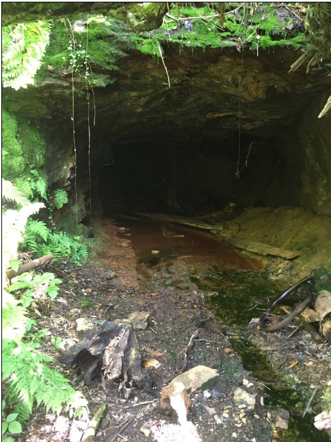
FIG. 7 INGRESSO GALLERIA S.OLGA
