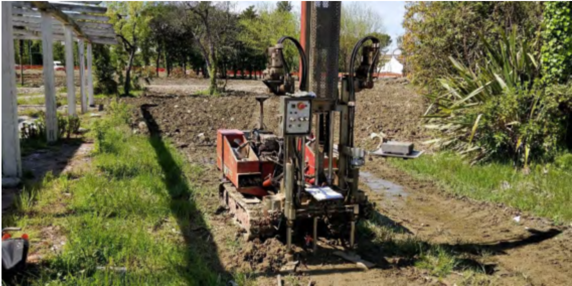
Figura 4 INDAGINE PENETROMETRICA DPSH1 ESEGUITA SUL SITO
