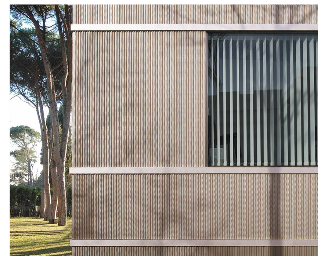
PARTICOLARE RIVESTIMENTO IN LAMIERA MICROFORATA
