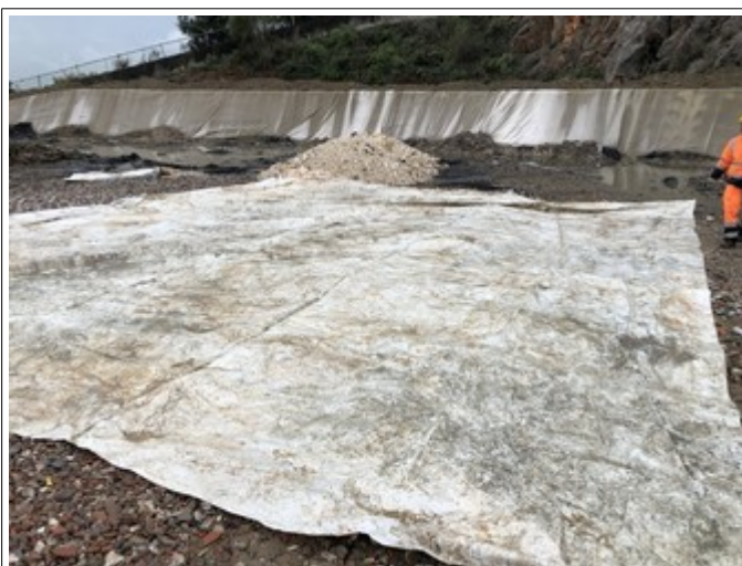
Foto 1: stesura telo PVC in plastica
