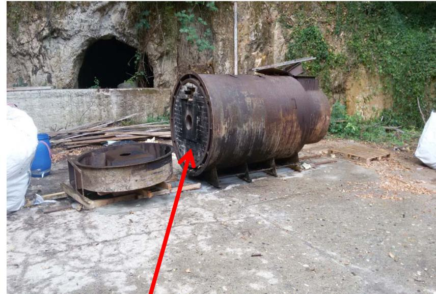
**E' stato necessario eseguire tutta la procedura di rimozione e smaltimento in previsione di presenza di amianto tipo friabile**
