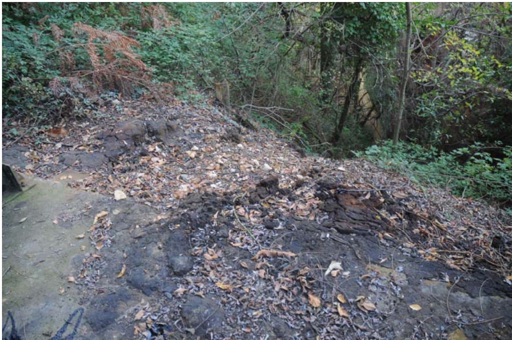
PAVIMENTO E SUOLO INTORNO ALLA CISTERNA DI NAFTA NERA
