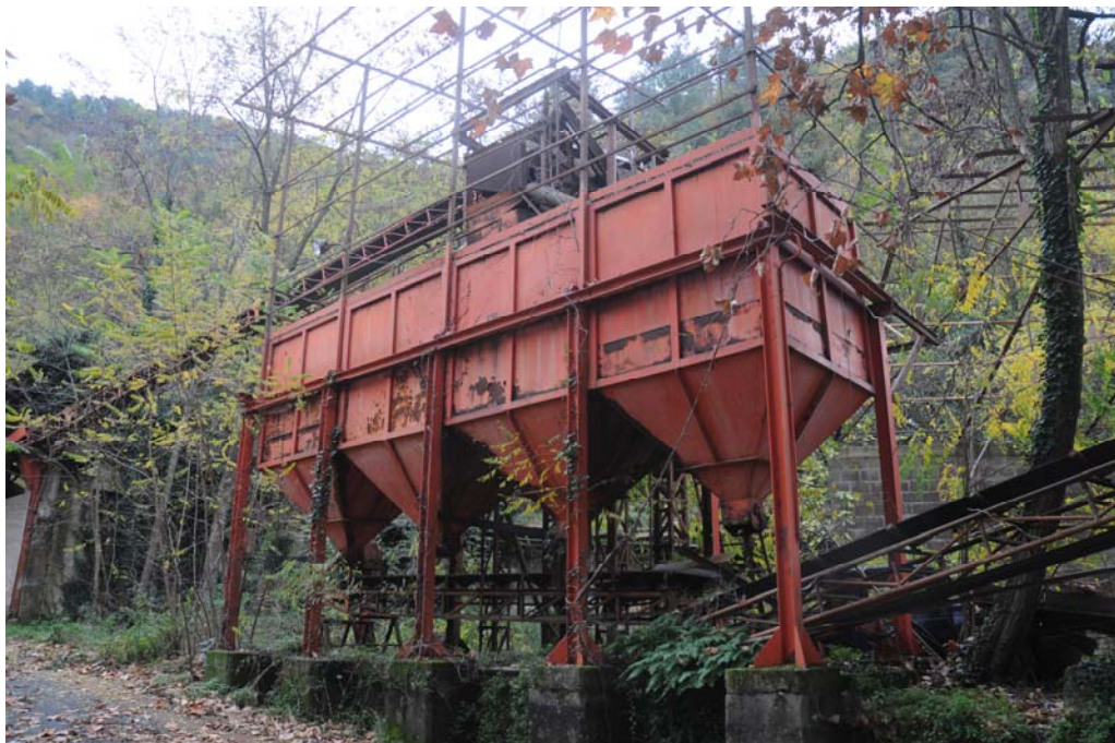
I SILOS DI BARITE EMATITICA
