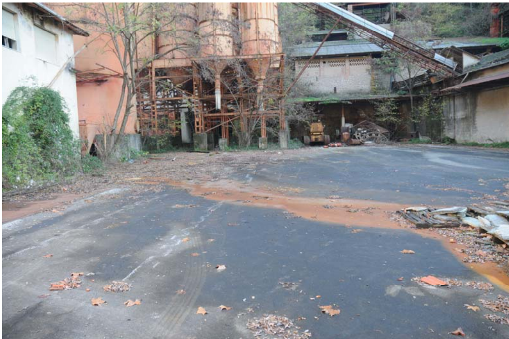
IL PIAZZALE INTERNO DELLO STABILIMENTO
