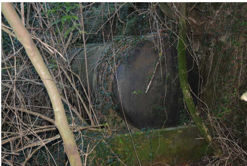
LA CISTERNA DI NAFTA
