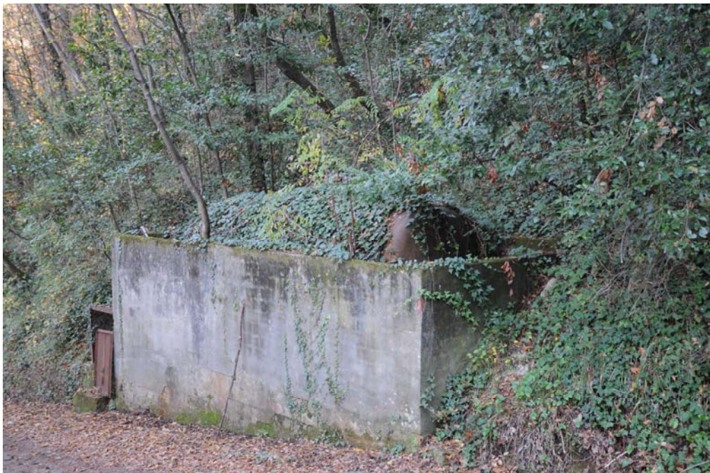
LA CISTERNA DI ACIDO SOLFORICO (VUOTA?)
