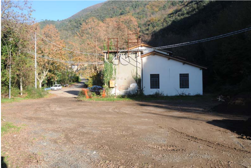
PIAZZALE ESTERNO A SUD-OVEST DELLO STABILIMENTO
