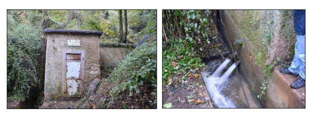
Fig. 4.10: Bottino di presa della sorgente Molini di S. Anna (a sinistra) e i relativi tubi di scarico (a destra).
