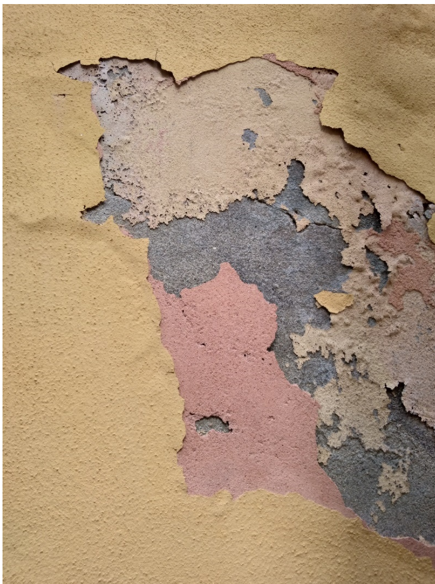
Fig. 3. Esempio di progressivi sollevamenti e distacchi di film pittorici e strati di finitura sovrapposti.
